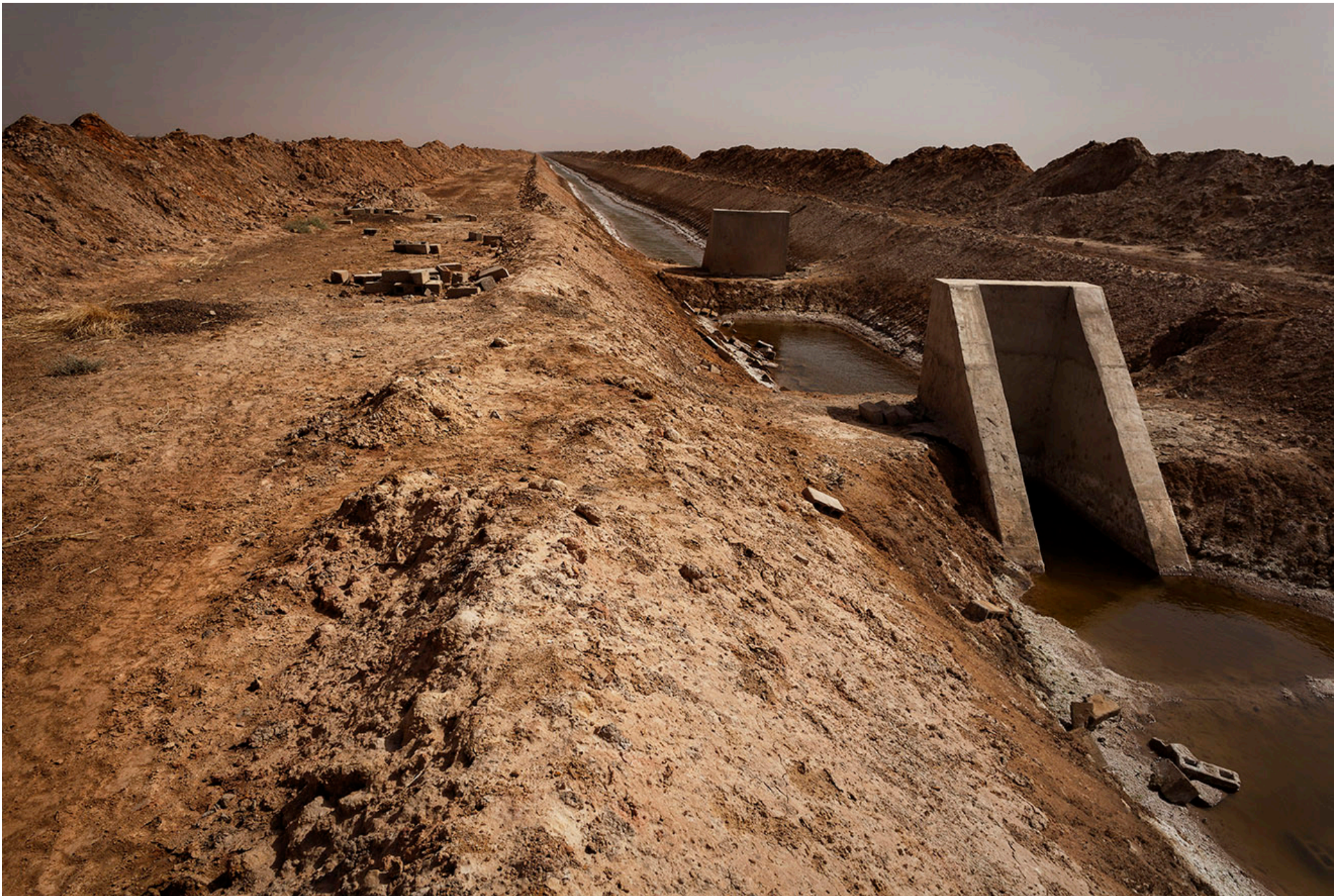
Costruzione di un canale nella riserva di Ndiaël, ad opera dell'azienda Senhuile-Sénhetanole.
