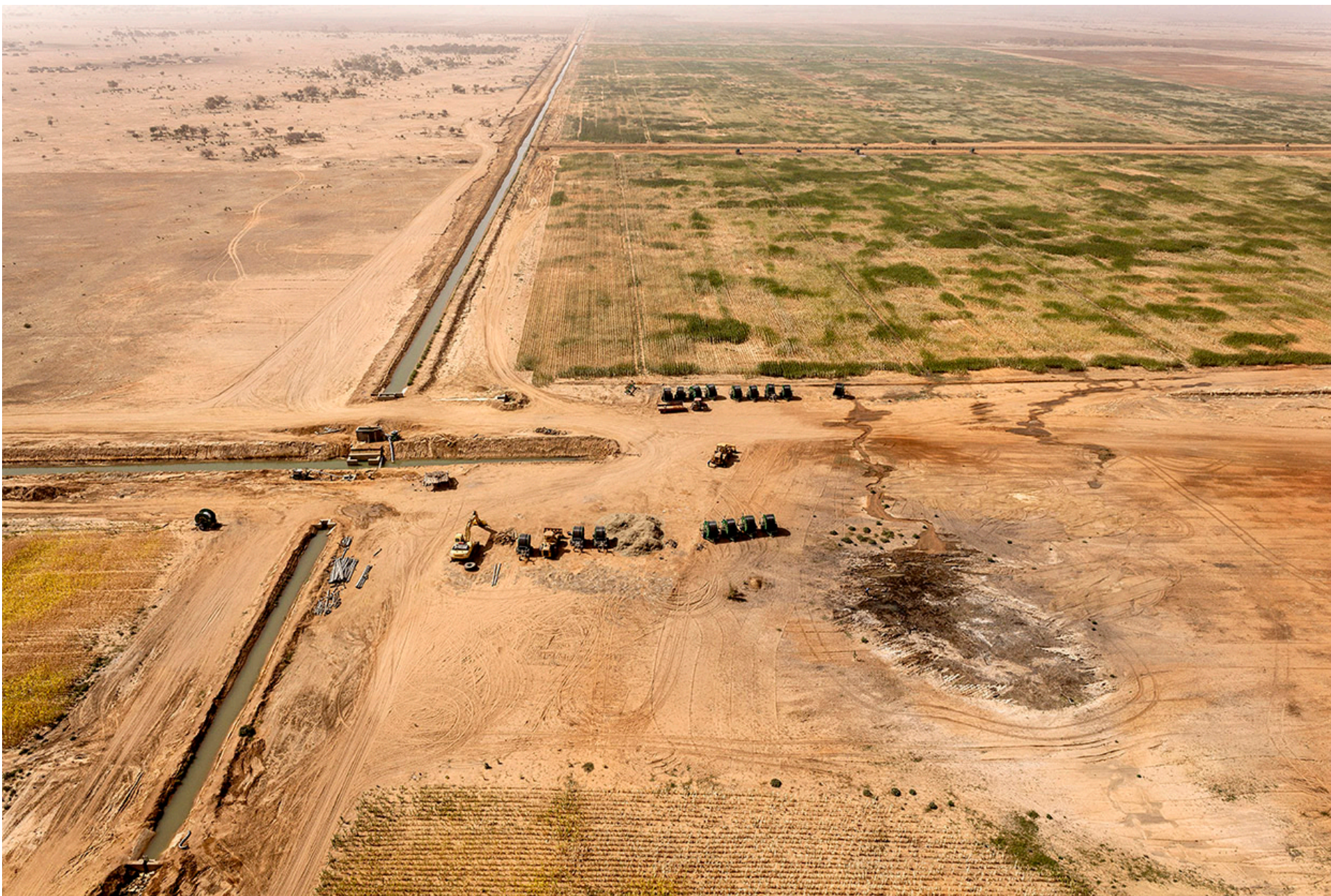
Lavori di canalizzazione, disboscamento, livellamento e coltivazione del terreno nella riserva di Ndiaël, per la realizzazione del progetto Senhuile.
